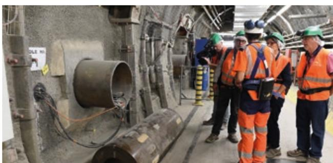
Figure 6 : Alvéoles de stockage expérimental
